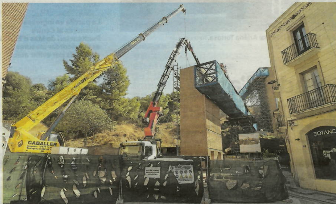
Maquinària de gran tonatge i grues instal·lant les passarel·les, a Tortosa. FOTO: J. REVILLAS
